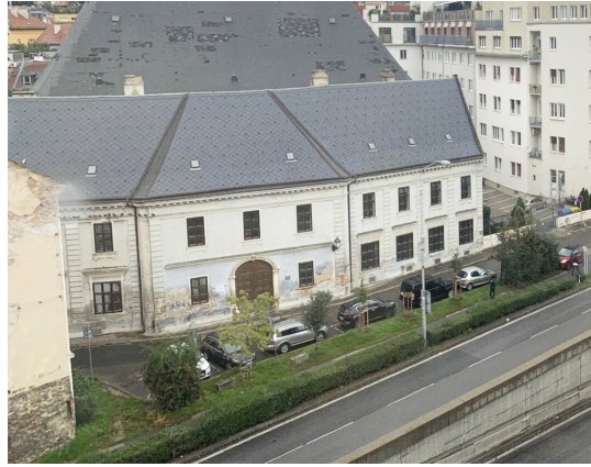
Rekonštrukcia lýcea a jeho okolia trvala dva roky.
