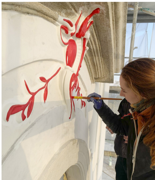
Práce na fasáde Prezidentského paláca.
